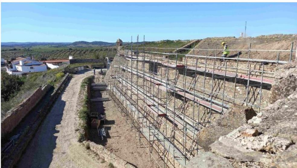
Para além da consolidação e reforço estrutural dos paramentos, sobretudo nas zonas mais degradadas, está também prevista a reconstrução de diversos tipos de alvenaria, como pedra, tijolo e taipa.
